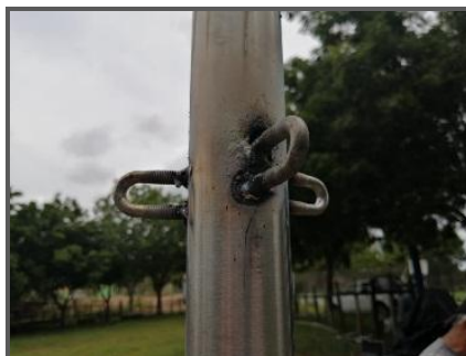
Figura 15. Soldadura de pernos en el mástil. Ilustración de trabajo conjunto SGC – IGAC.
