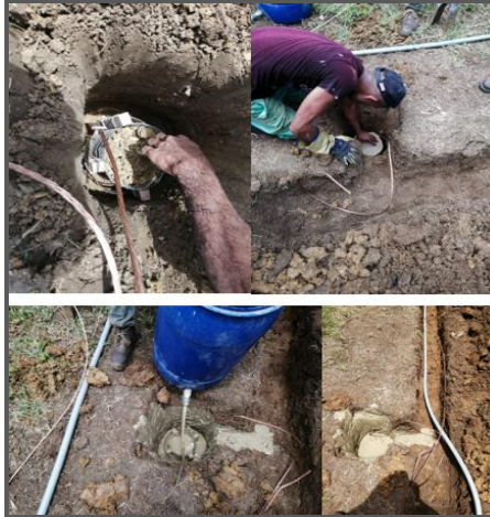
Figura 10. Instalación puesta a tierra. Ilustración de trabajo conjunto SGC – IGAC.
