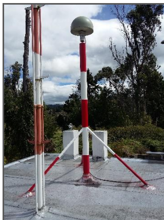
Figura 44. Materialización tipo Mástil terminada. Antena GNSS instalada. Recuperado de: Elaboración propia.
