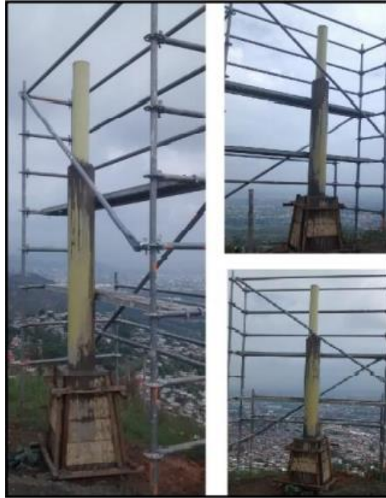
Figura 61. Armado cilindro 2, tubo PVC (1,2 m x 6"). Recuperado de: Elaboración propia
