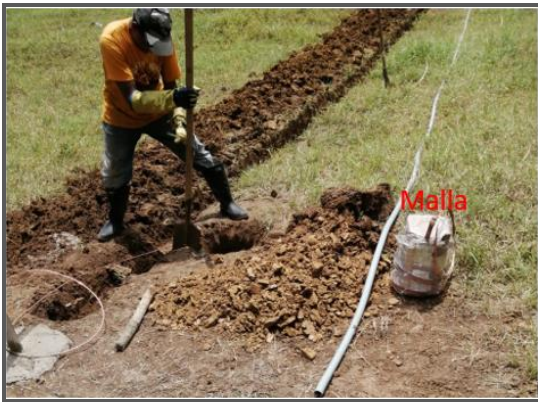
Figura 9. Instalación puesta a tierra. Ilustración de trabajo conjunto SGC – IGAC.
