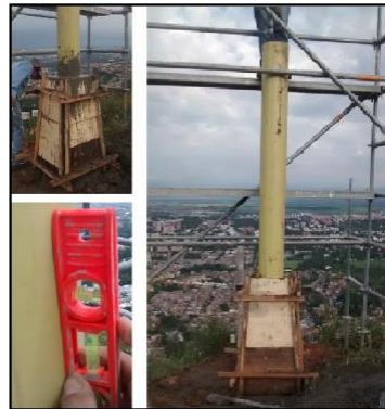
Figura 60. Armado cilindro 1, tubo PVC (3 m x 10"). Recuperado de: Elaboración propia.
