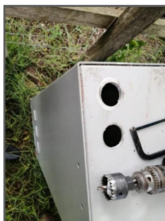
Figura 20. Preparación del Gabinete. Ilustración de trabajo conjunto SGC – IGAC.
