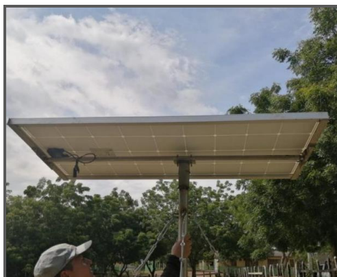
Figura 19. Instalación paneles solares. Ilustración de trabajo conjunto SGC – IGAC.
