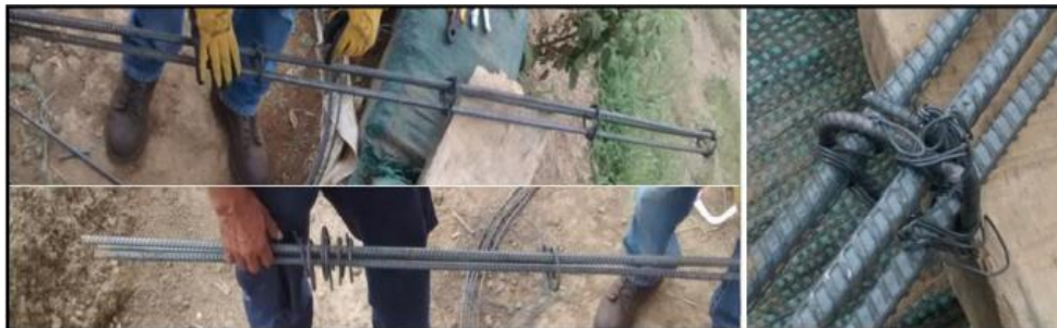
Figura 55. Armado hierro, base plato de acero (rosca hembra en el centro). Recuperado de: Elaboración propia.
