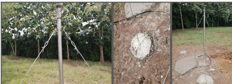
Figura 17. Instalación de tensores. Ilustración de trabajo conjunto SGC – IGAC.
