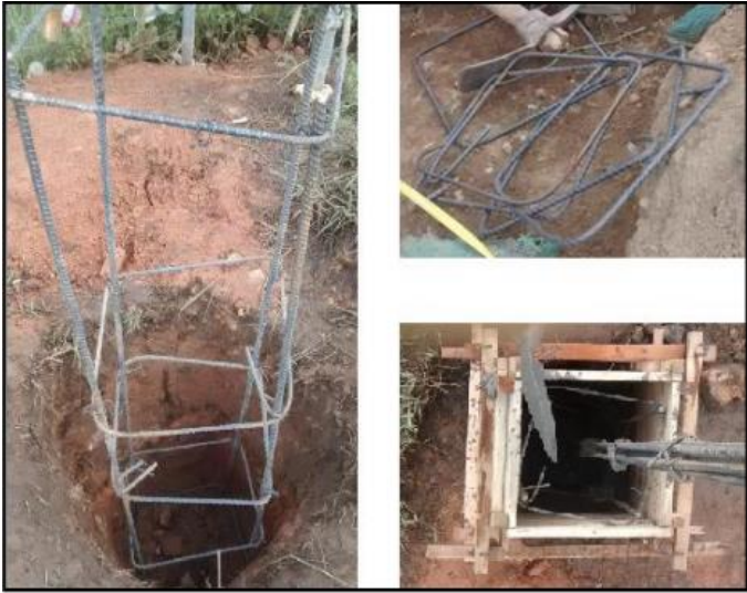
Figura 57. Armado estructura y formaleta de prisma rectangular recto y tronco de pirámide. Recuperado de: Elaboración propia.
