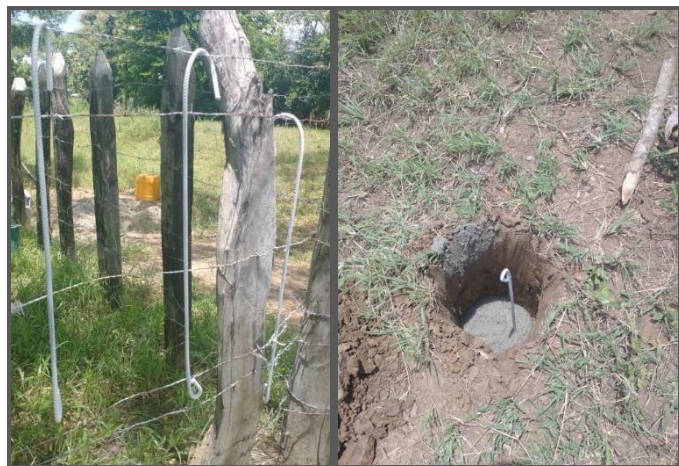
Figura 13. Instalación templetos. Ilustración de trabajo conjunto SGC – IGAC.
