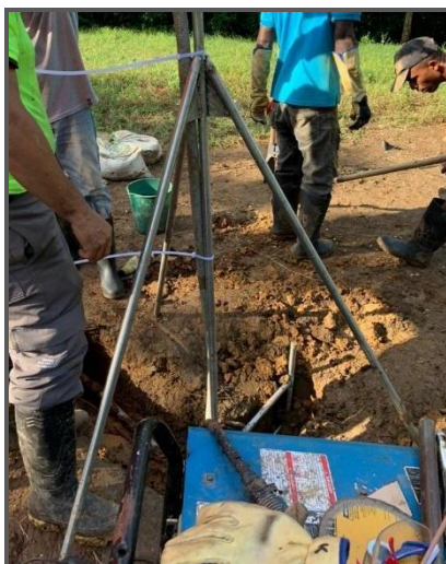
Figura 30. Construcción de trípode de soporte. Ilustración de trabajo conjunto SGC – IGAC.
