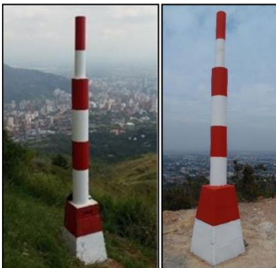
Figura 64. Materialización tipo obelisco terminada. Recuperado de: Elaboración propia.
