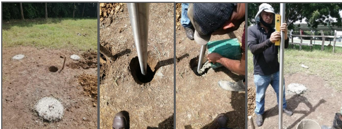
Figura 14. Instalación templetas. Ilustración de trabajo conjunto SGC – IGAC.
